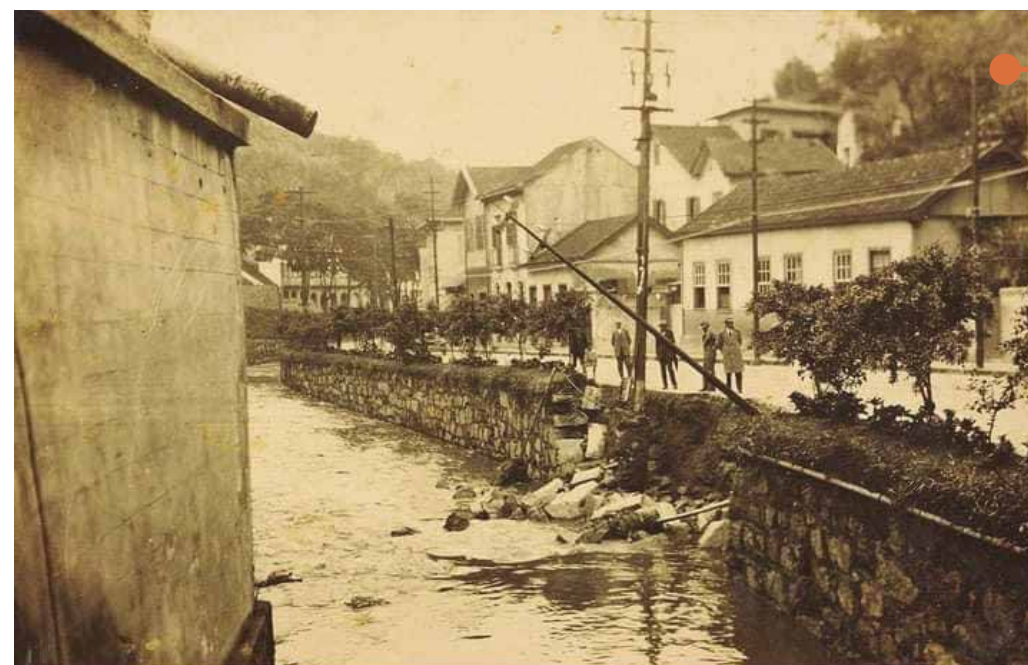
83 Petrópolis, década de 1930. Queda, após enchente, da mureta na rua 14 de julho, atual rua Washington Luis, em frente à Fábrica São Pedro de Alcântara. Tribuna de Petrópolis.
